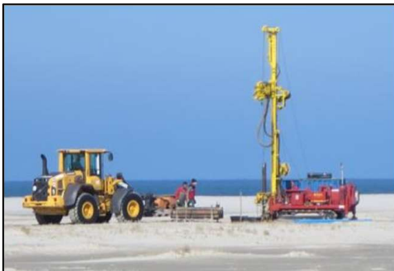
Wissenschaftliches Bohren Messstellenbau
