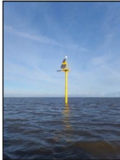
Abbildung 3: Vergleichbare Messpfähle des NLWKN auf Norderney an ähnlicher Position im Intertidal.
