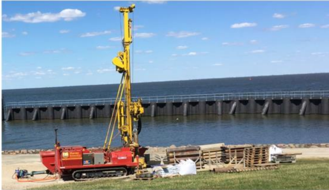
Abbildung 5: Bohranlage der Firma Harms mit Ausrüstung.
