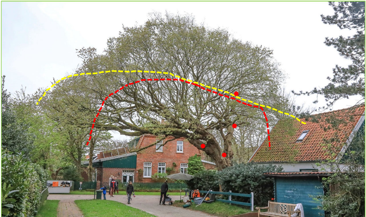
Abb. 6-3: Rote Linie als Schnittskizze Lastrichtung 1, starke seitliche Einkürzung und in der Höhe
