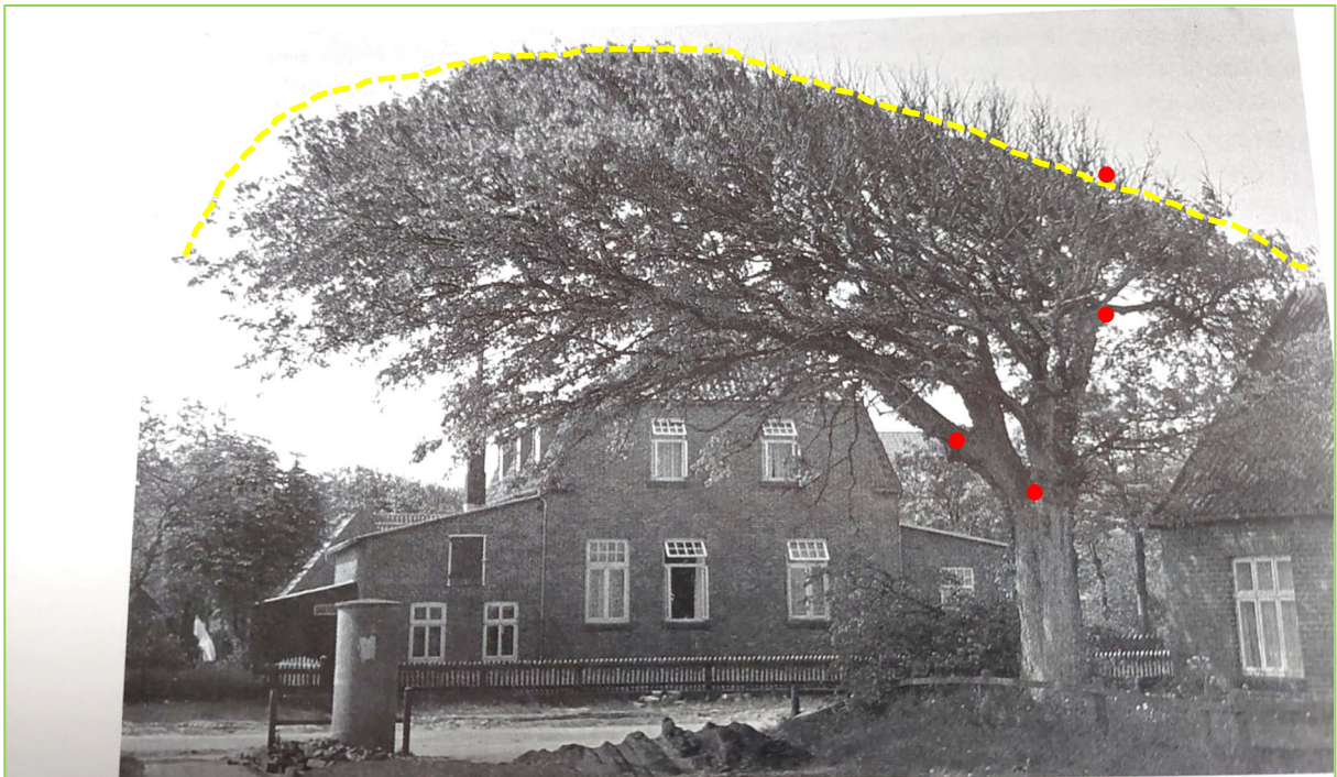
Abb. 3-3: Ansicht der Ulme vor Jahrzehnten; Bild wurde vom Auftraggeber ohne weitere Quellenangabe zur Verfügung gestellt. Die Veränderung der Wuchsform mit Tendenz nach oben ist deutlich zu erkennen.
